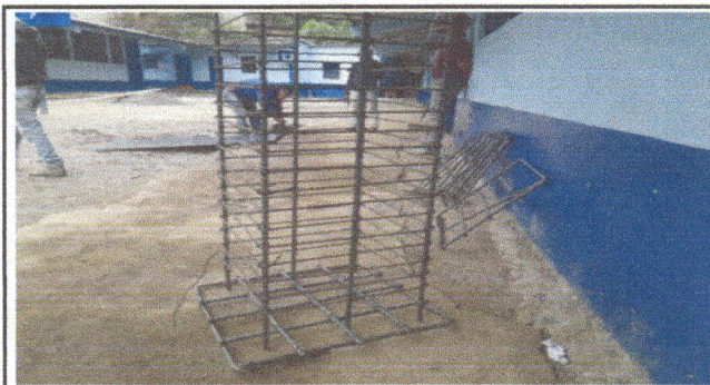
Foto 4: Armadura para zapatas
