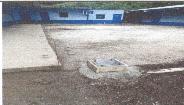
Foto 1: Fundición de las zapatas
