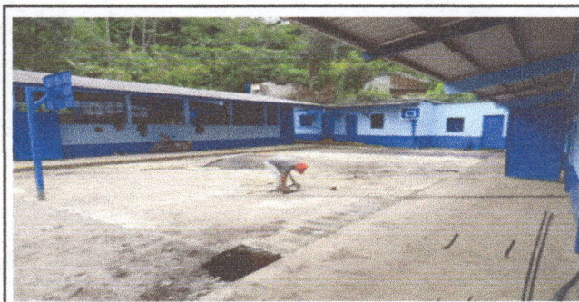
Foto 6: Sanjeado para la viga tipo H
