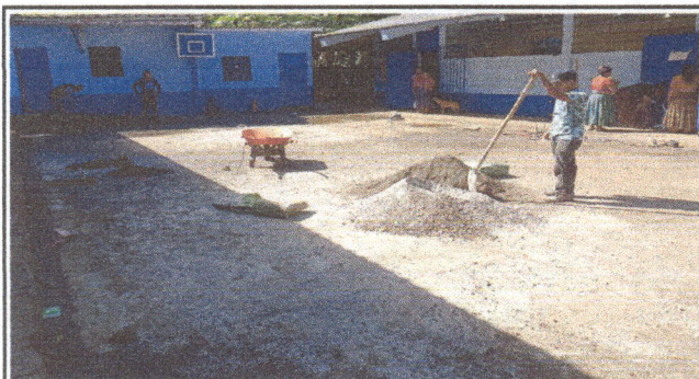
Foto 3: Mescla de concreto para fundicion
