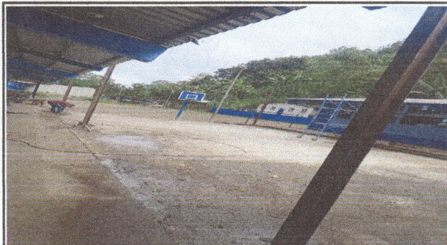
Foto 2: Puesta de las vigas tipo H
