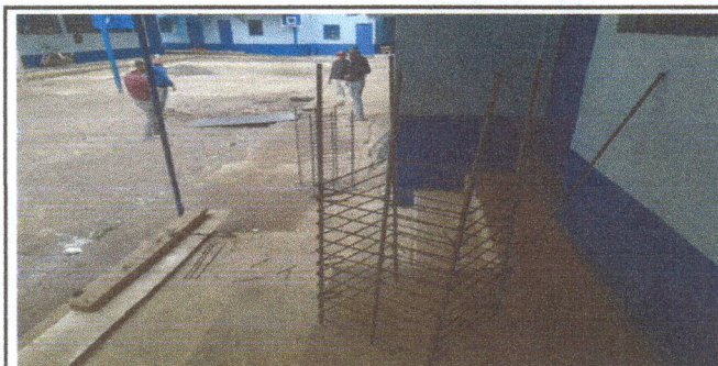
Foto 5: Corte de plancha de lamina .
